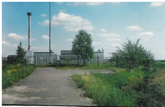
Газорозподільна станція (ГРС)
